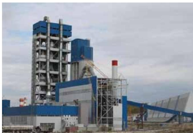
Рис. 2. Новая технологическая линия сухого способа производства на ОАО «Мордовцемент»
