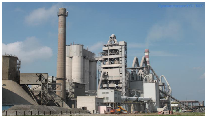
Рис. 1. Общий вид Белорусского цементного завода
