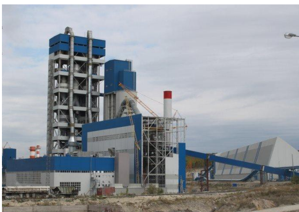
Рис. 2. Новая технологическая линия сухого способа производства на ОАО «Мордовцемент»
